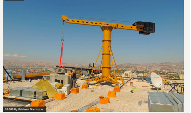
10.000 Kg Kaldırma Operasyonu
